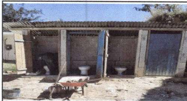
Foto 6: Sustitución de 3 inodoros
