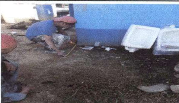
Foto 5: Sustitución de mingitorios
