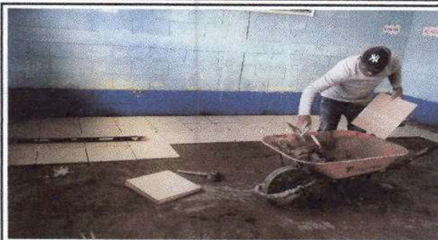
Foto 2: Sustitución de piso cerámico
