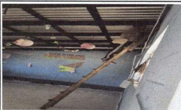
Foto 3: Sustitución de cableado eléctrico y accesorios
