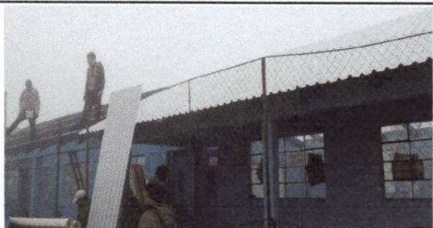
Foto1: Sustitución de techo por lámina troquelada
